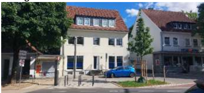
Bild: Die neue Geschäftsstelle in Soest
